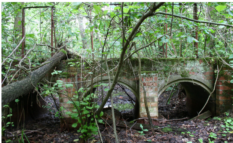
Abb. 4) Stauwehr im Graben einer ehemaligen Bewässerungswiese – erkennbar sind noch die Metallrahmen der hochgezogenen Schütten
